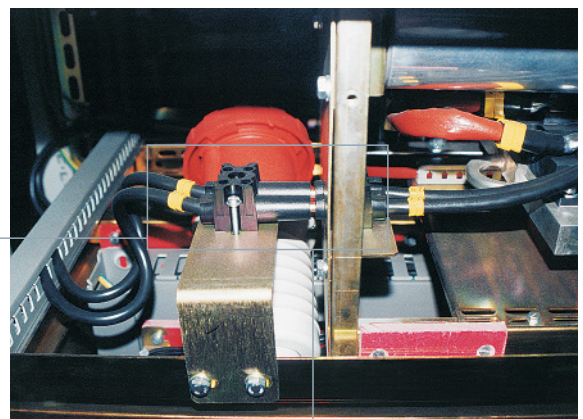
Buchsen- und Steckerleiste-Element P1/100... in einem Einschub
